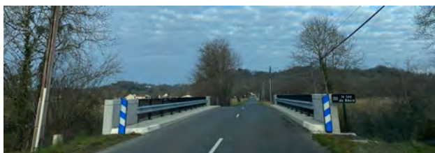
En projet, le recalibrage de la RD946 à partir du Pont de Luy de Béarn jusqu'au premier virage de la côte de Morlanne.
